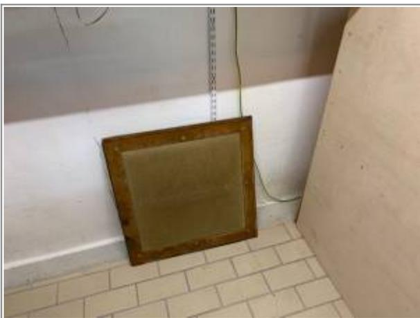
Rahmen mit Grobfiltern nach außen ziehen. So wenig wie möglich und langsam bewegen.
